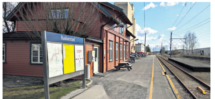
STASJON: I Rakkestads nedlagte stasjonsbygning ligger Perrongen cafe. Håpet er at skinnegangen sydover vil bli mer brukt etter en kommunesammenslåing. Strekingen mellom Rakkestad og Sarpsborg har det mest moderne signalanlegget i Norge.
